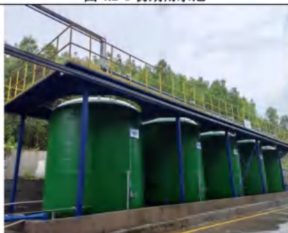
图 4.2-8 氨水储罐围堰
