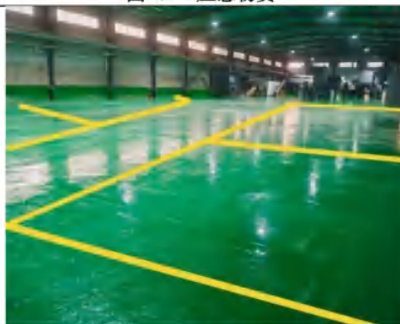
图 4.2-4 防腐防渗地面
